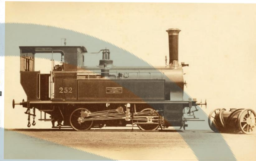
Die Maschinenfabrik Esslingen lieferte daraufhin vier dreifach gekuppelte Lokomotiven mit gleichen Abmessungen für reinen Reibungsbetrieb. Unversehrt war der Einstieg der ME in das Geschäft mit Bergbahnen
